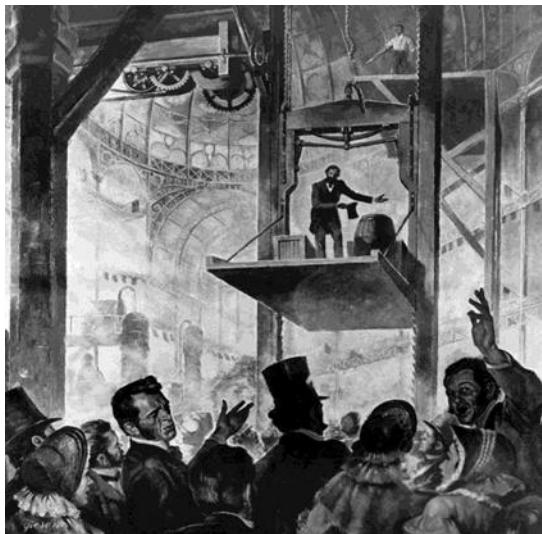
En 1852, Elisha Otis a introduit l'ascenseur de sécurité, qui empêchait la chute de la cabine en cas de rupture du câble. L'ascenseur fut présenté lors de l'exposition de New York au Crystal Palace dans le cadre d'une présentation périlleuse en 1854. Le premier ascenseur de ce genre a été installé au 488, Broadway dans la ville de New York le 23 mars 1857.
